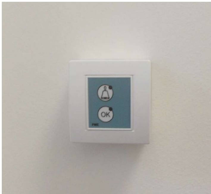
Тастер за позивање припадника обезбеђења у реновираним спаваоницама
